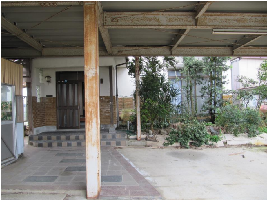
外観(玄関アプローチ、カーポート及び庭)
